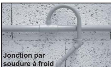
Jonction par soudure à froid
