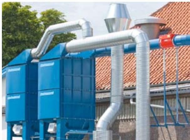
Les filtres FilterMax DX sont conçus selon la directive ATEX. Le système est pourvu d'un panneau de rupture.
