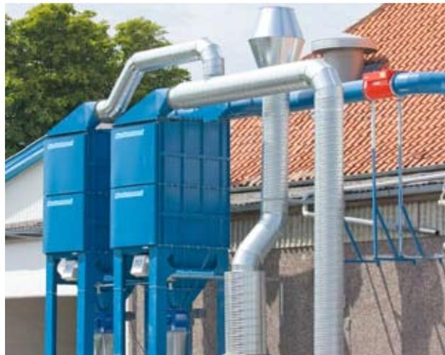
Les travaux sur des matériaux composites produisent des poussières et des fibres. Ces particules sont assez petites pour pénétrer dans les poumons des êtres humains et sous la peau, causant des réactions allergiques. Le moyen le plus efficace de réduire ces risques est d'extraire ces substances directement à la source.
