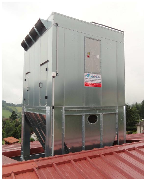
Les châssis de rehausse peuvent être réalisés en acier galvanisé ou en poutrelles de type IPN (ou équivalent). Leur intérêt est de surélever le groupe filtrant afin d'y loger une benne (ou autre conteneur) dessous. Nous nous adaptons à toutes les contraintes possibles (installation en toiture), hauteur sur mesure, etc.).
