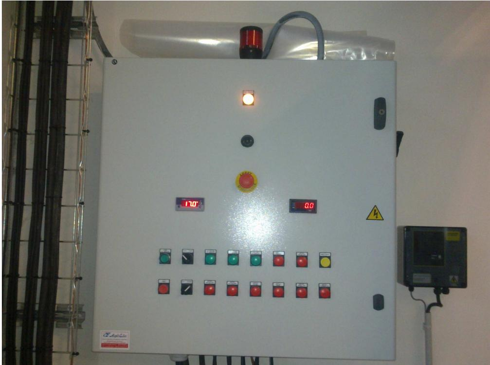
Exemple de coffret électrique pour aspiration avec filtre
