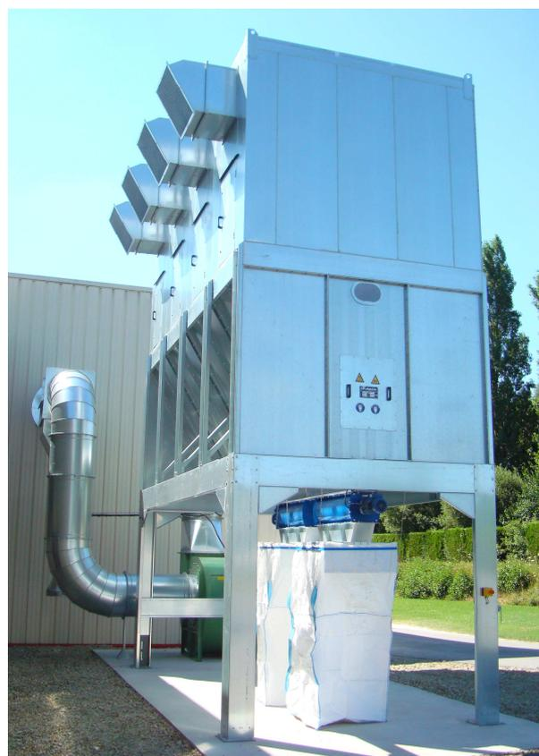
**Système de secouage automatique des manches par moto-vibreurs électrique**
